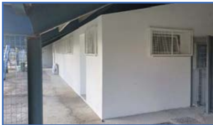
NUOVI SPOGLIATOI - SOTTOTRIBUNA CENTRALE
