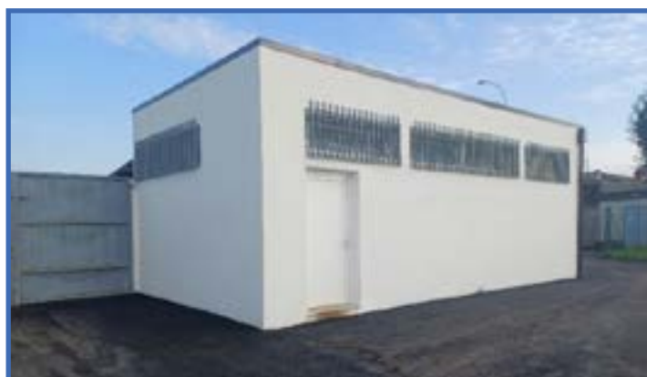
NUOVI SPOGLIATOI - SOTTOTRIBUNA CENTRALE
